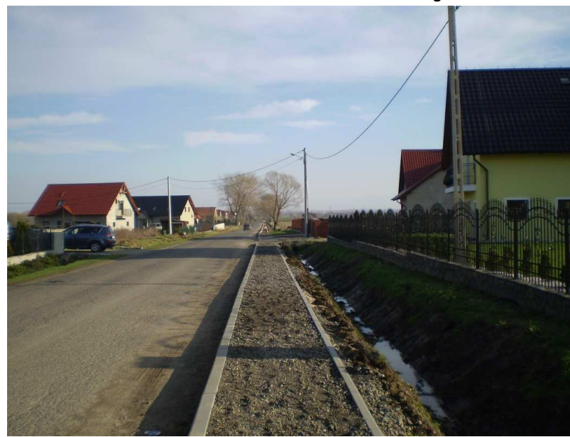
Chodnik w trakcie realizacji.
