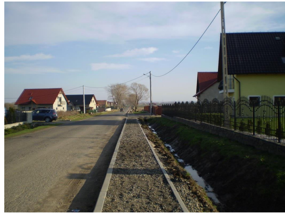
Chodnik w trakcie realizacji.
