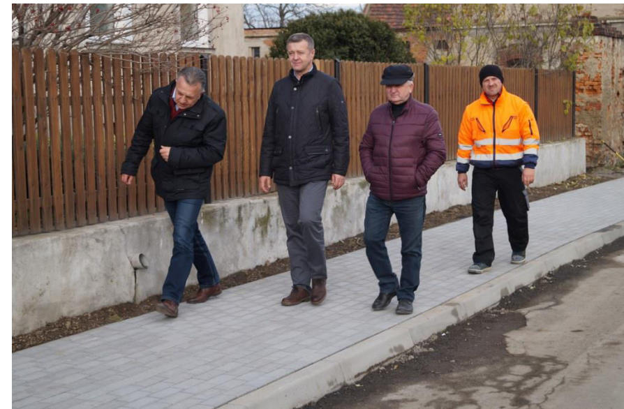
Chodnik w trakcie realizacji.
